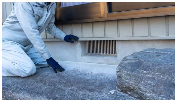
■床下通気口（四角い格子付きの換気口）
