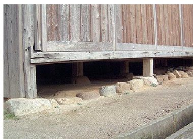
■古民家の床下
