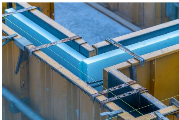
■基礎断熱工法（特に北海道などの北国）
