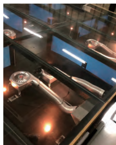
■ブロー型換気扇設置
