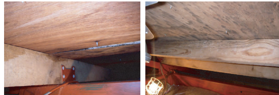
換気扇を運転し通風効果により結露発生抑制効果が認められた。
