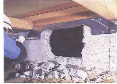
弱った基礎と土間にオールアンカー・コーチスクリュー・専用トラスティックでキソフレームをガッチリ取り付け、補強します。
