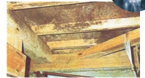
床下換気を行わなかった床下(築5年)
