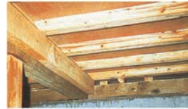
床下換気を行った床下(築5年)
