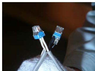
⑧コネクタにキャップを被せてビニルテープを半幅以上重ね3回以上巻いて固定してください。
