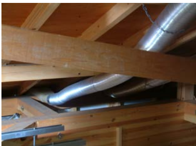
⑮フレキシブルカップリングに固定したアルミダクトを本体まで伸ばし、粘着テープで固定する。
