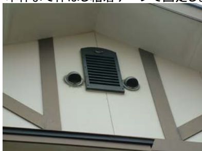
⑧施工完了 ※パイプフードは必ず標準付属品を ご利用ください。市販品では風量の低下や ネットの目づまり等不具合が発生する 可能性があります。
