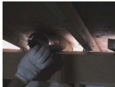
⑫天井裏に差し込んだフレキシブルカップリングの位置を決め、先端の形を整えてください。
