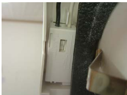
③VVFケーブルを段剥きして 給気電動シャッターに配線します。
