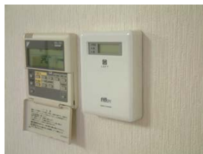
⑫最後に動作チェックをしてタイマーカバーをかぶせて結線完了。
