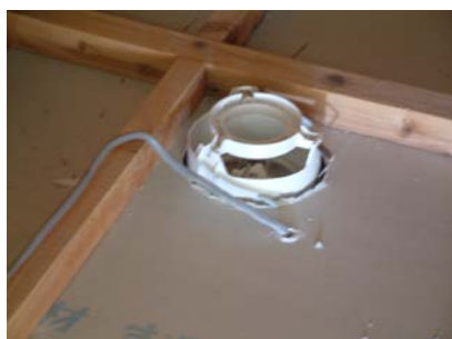
⑨天井裏から見た補強材との位置関係。
