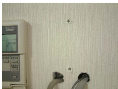
⑧パネルなどの壁面に取り付ける際は プラスチックアンカーを使用してください。
