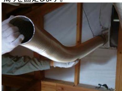
⑥パイプフードに取り付けたアルミダクトを 本体まで伸ばし粘着テープで固定します。
