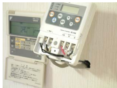
⑥結線完了。 電線の色に注意してください。
