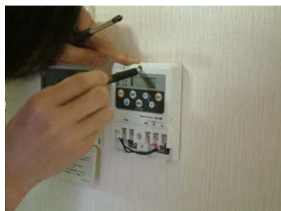
②取付け用下穴の位置決めをします。
