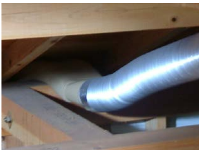
⑬天井裏側のフレキシブルカップリングとアルミダクトを粘着テープで固定する。
