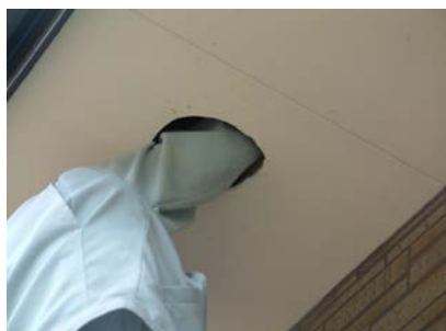
⑦ 軒天に入れたフレキシブルカップリングを天井裏へ差しこみます。アルミダクトは軒天板の穴から外側に出してください。
