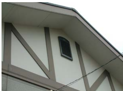
①施工前の外観
