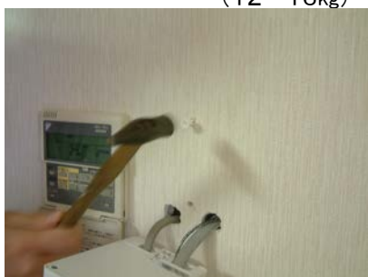
⑦φ6の下穴を開けプラスチックアンカーを打ち込みます。
