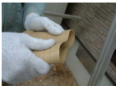
⑤ 天井裏側へ差し込むフレキシブルカップリングの先端をつぶしておくとしこみがスムーズです。
