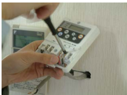
⑤電線の先端が突き当たるまで差込み 端子ねじを確実に締めます。 ※適正締め付けトルク1.2～1.6N・m (12～16kg)
