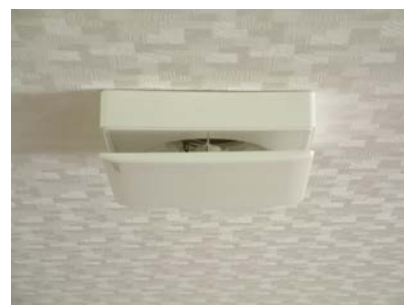
⑩換気システムと連動しているか動作チェックをして取り付け完了。
