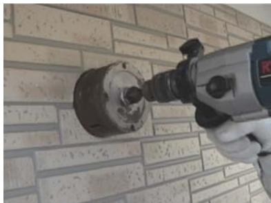
②外壁にφ105～110の穴を開けます。 ※下穴は、壁厚さ10mmまではφ105 それ以上はφ110で開けてください。
