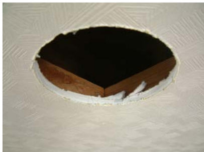
①φ150の穴を開けます。 シャッター固定ねじが天井裏の補強材に しっかり固定できるような所を選びます。
