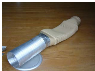
④ カットしたアルミダクトをフレキシブルカップリングに粘着テープで固定します。
