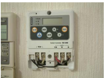
⑪端子カバーをかぶせて必ずねじで固定してください。
