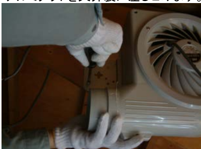
⑤本体を天井裏の中央の高さに取り付けます。
