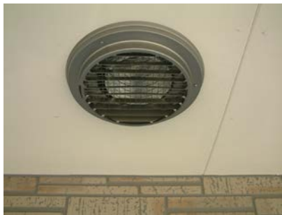
⑪ルーバーをネジで固定する。 ※外側に吹き出し風が出るようルーバー向きに注意すること。
