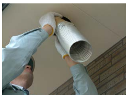
⑥ フレキシブルカップリングを軒天板の穴から軒先へ差しこみます。
