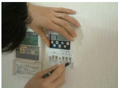
①コントローラーの取り付け位置を決める。
