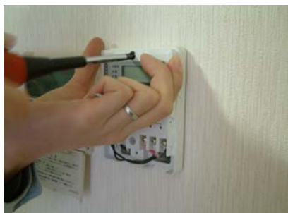
⑨コントローラーをねじで固定します。
