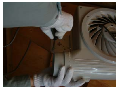
⑭本体を天井裏の高い位置に取り付けます。
