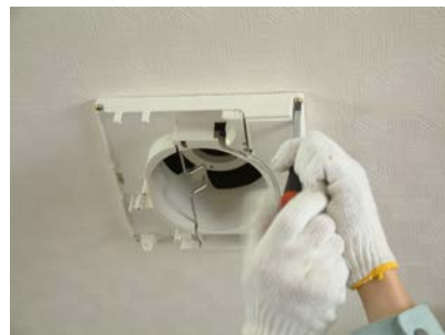
④給気電動シャッターと配線したVVFケーブルを 差しこみ、ねじで4箇所固定してください。
