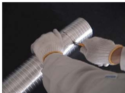
② アルミダクトを3～400mm長にカットします。
