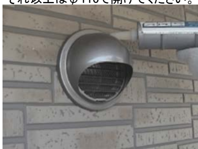
④市販のコーキング材でパイプフードの 周りを固定します。
