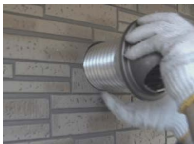
③外壁側からパイプフードを取付けた アルミダクトを天井裏に差しこみます。
