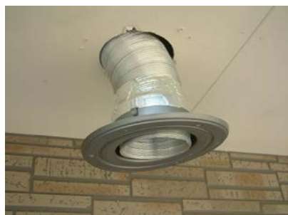
⑧ 丸・平型換気口のルーバーを外しアルミダクトを内径に挿入し、先端を換気口吹出し面にあわせて粘着テープで固定する。
