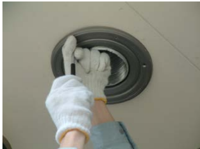
⑨丸・平型換気口を軒天側に押込んでネジで固定する。
