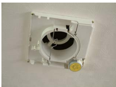
⑤しっかり固定されているか確認し、 開閉カバーを取り付けます。
