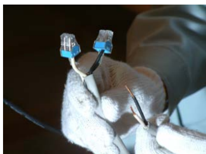
⑦給気電動シャッターに配線したVVFケーブルを換気システムの電源コードに差し込んでください。
