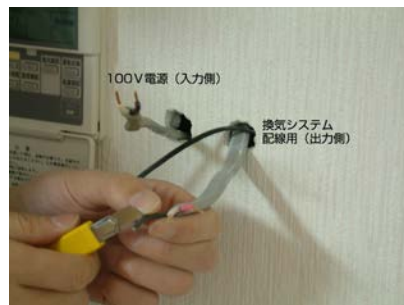
④天井裏の本体からの配線を引き出し VVFケーブルを段剥きする。
