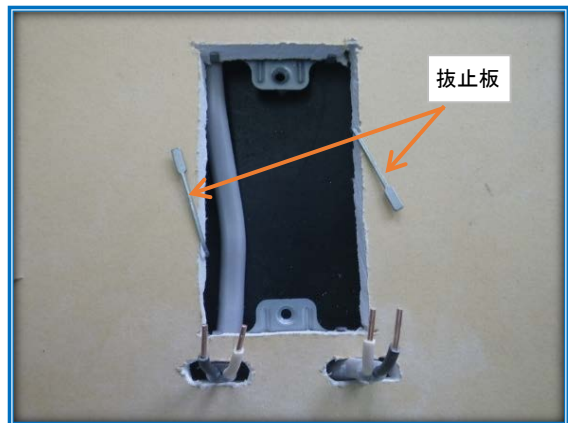
③押え金具の挿入し、抜止板を表側に曲げて、配線を出す。
