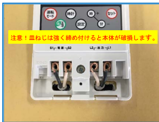
⑤タイマーを金具付属の皿ねじで固定し、端子ねじを外し、電線を接続する。
