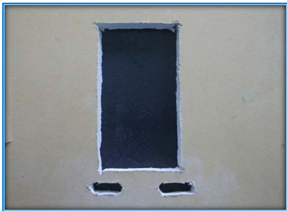
①石膏ボードに穴を開ける。(寸法別紙参照)
