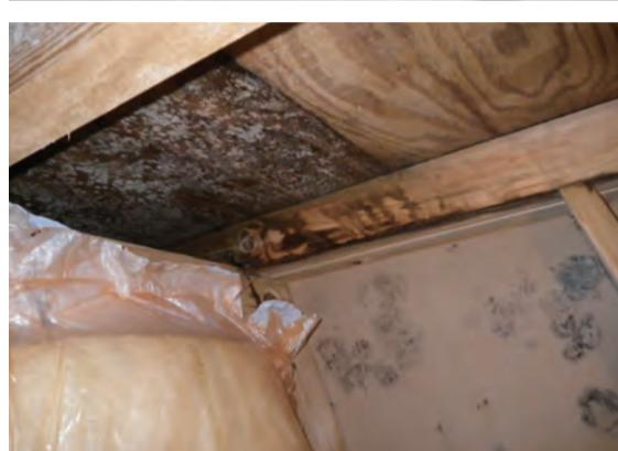
滴（結露）になるのです。初秋は雨が多く、初夏も梅雨季があり、湿度も高くなっています。木材は呼吸（吸放湿）しますが、放湿する力より吸湿する力が弱いため結露になりやすいのです。そのなかで一番恐いのは腐朽菌の発生です。木材の含水率が上昇し、25%から腐朽菌が生育し、さらに30%を超えると増殖を始めます。この腐朽菌は木材そのものを腐らせ、強度を大きく弱らせるためもっとも怖いものです。(図6)
