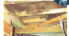
床下換気を行わなかった床下(築5年)
